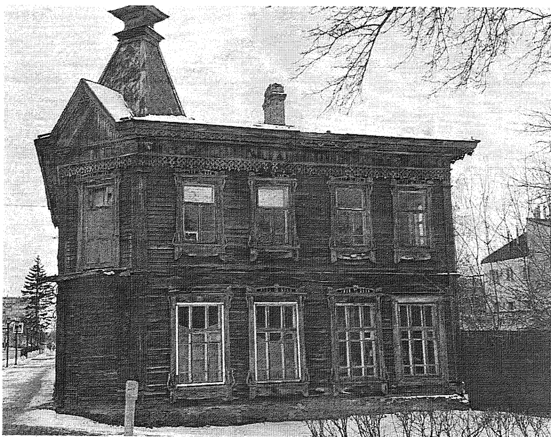
Фото 3 от 28.11.2023. Юго-западный фасад здания.
