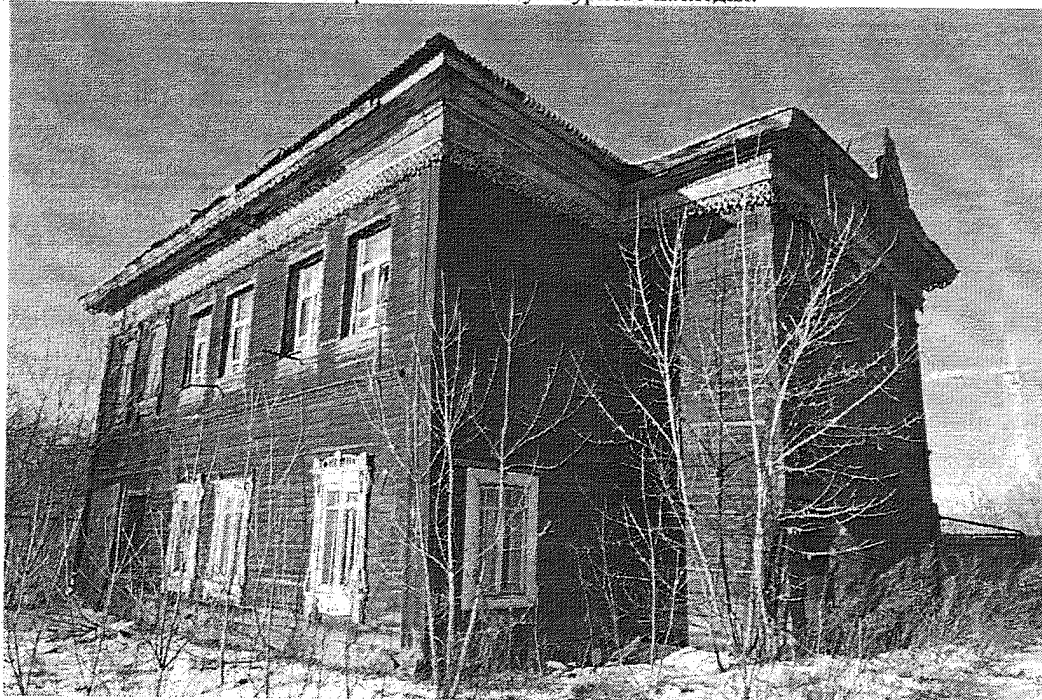
Фото 2 от 28.11.2023. Юго-восточный фасад здания.
