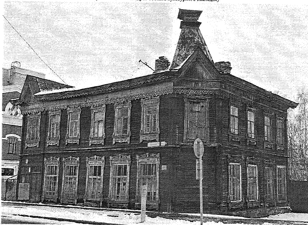
Фото 1 от 28.11.2023. Главный фасад объекта культурного наследия.
