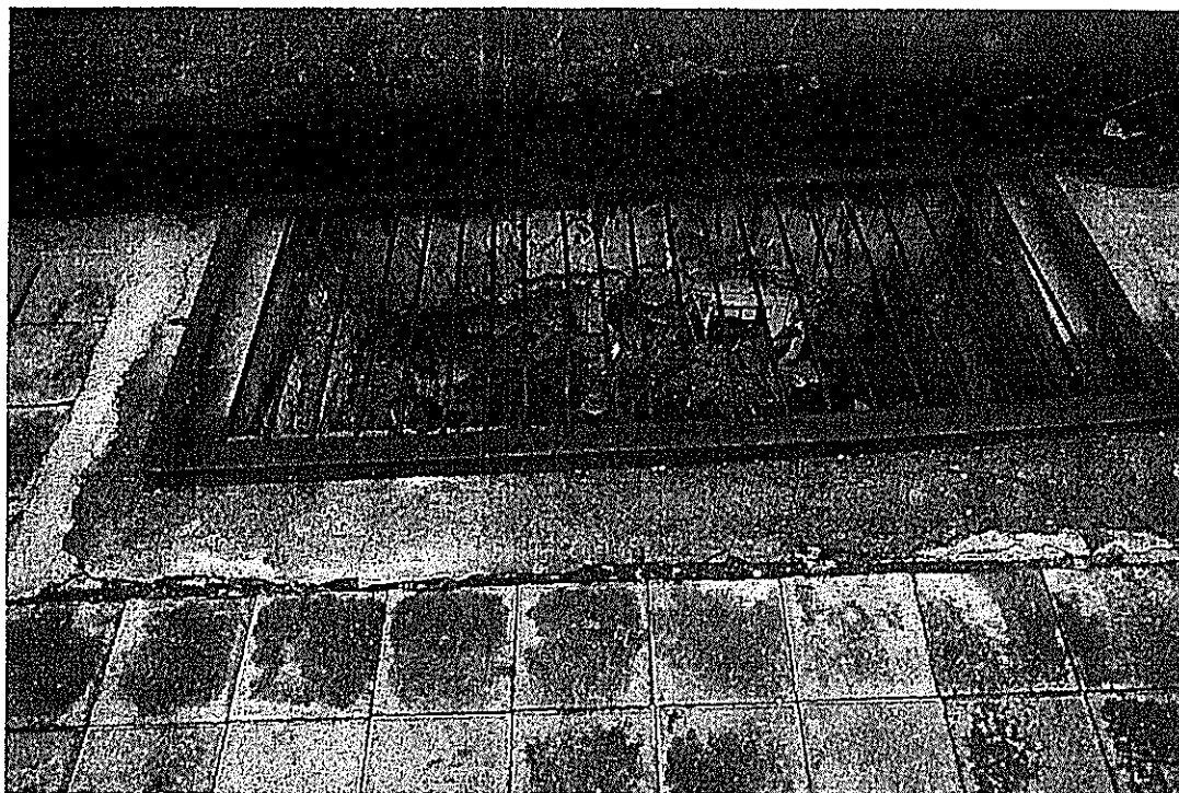
Рис. 3 Фрагмент цокольной части главного юго-западного фасада. Прямок.
