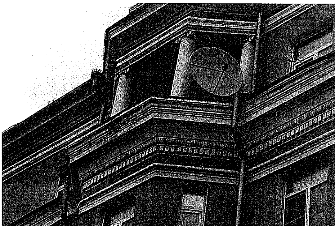
Рис. 2 Фрагмент главного юго-западного фасада. Разрушения декоративных элементов.
