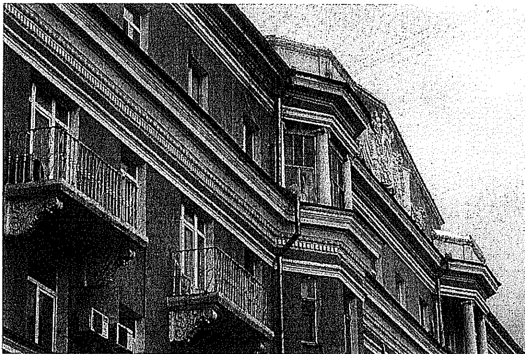
Рис. 1 Фрагмент главного юго-западного фасада. Намокание поверхности стен и декоративных элементов в местах расположения водосточных труб.
