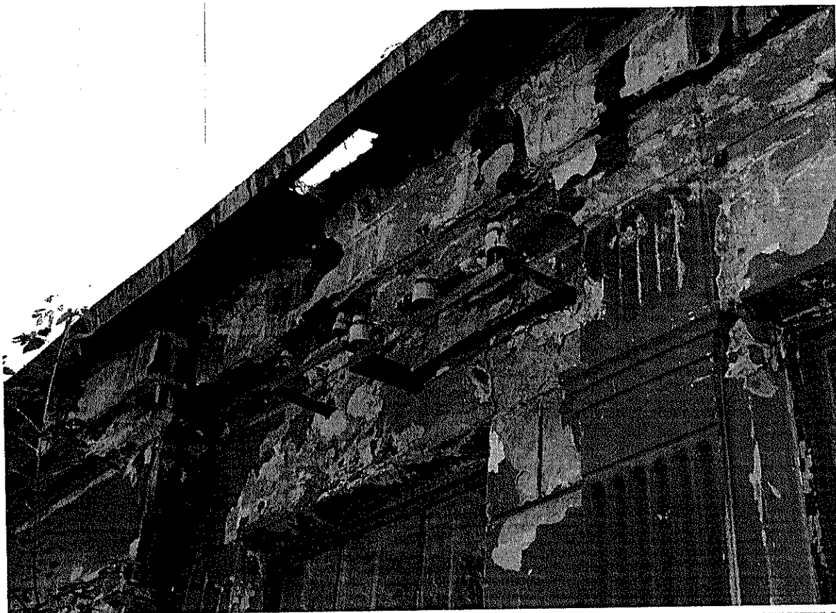
Фото 4 от 18.08.2021. Фрагмент юго-западного фасада. Нарушение целостности кровельного покрытия и карниза, повреждение отделочного слоя фасада.
