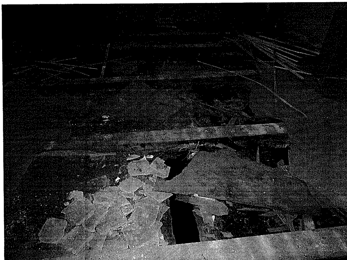
Фото 8 от 18.08.2021. Внутренние помещения. Нарушение целостности полов.
